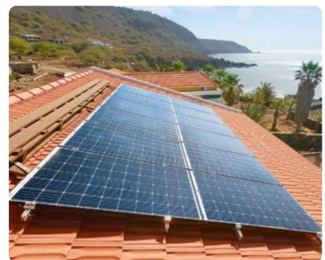
**Fig. 40** Painéis fotovoltaicos usados para fornecer eletricidade a uma habitação.
