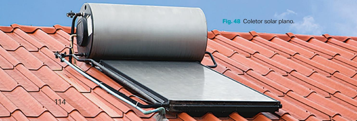
Fig. 48 Coletor solar plano.
