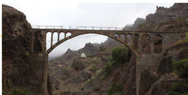
Fig. 24 Ponte de Canal é uma infraestrutura hidráulica construída na ilha de S. Antão em 1956.
