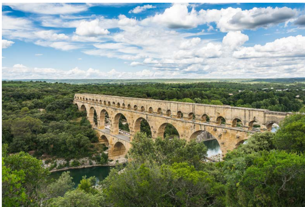
Fig. 33 Ponte du Gard, França.
